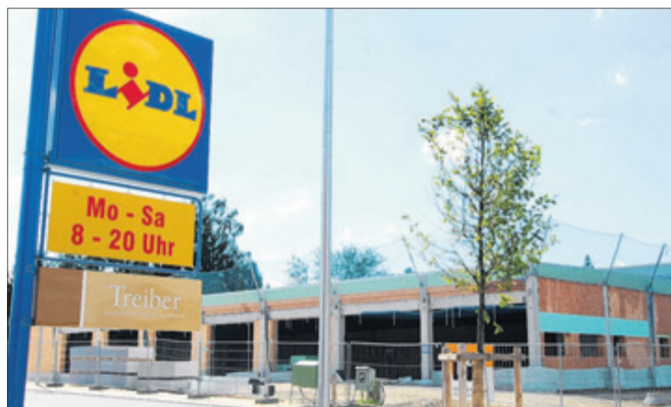
Bei der Lidl-Filiale an der Osttangente Plattenhardt entsteht der neue dm-Markt. Foto: Bergmann
